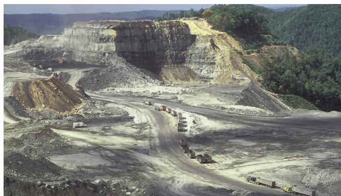
**Figura 6.29.** Mina de carbón a cielo abierto en los Apalaches centrales, USA. Nótese el notable espesor de las capas de carbón resultante de la mayor subsidencia de este sector de la cuenca. Arriba del carbón hay pelitas oscuras con fauna marina sobre las que progradan areniscas deltaicas y fluviales (capas de color claro). Los estratos corresponden al Grupo Allegheny del Pensilvaniano medio (Desmoinesiano de la escala local).
